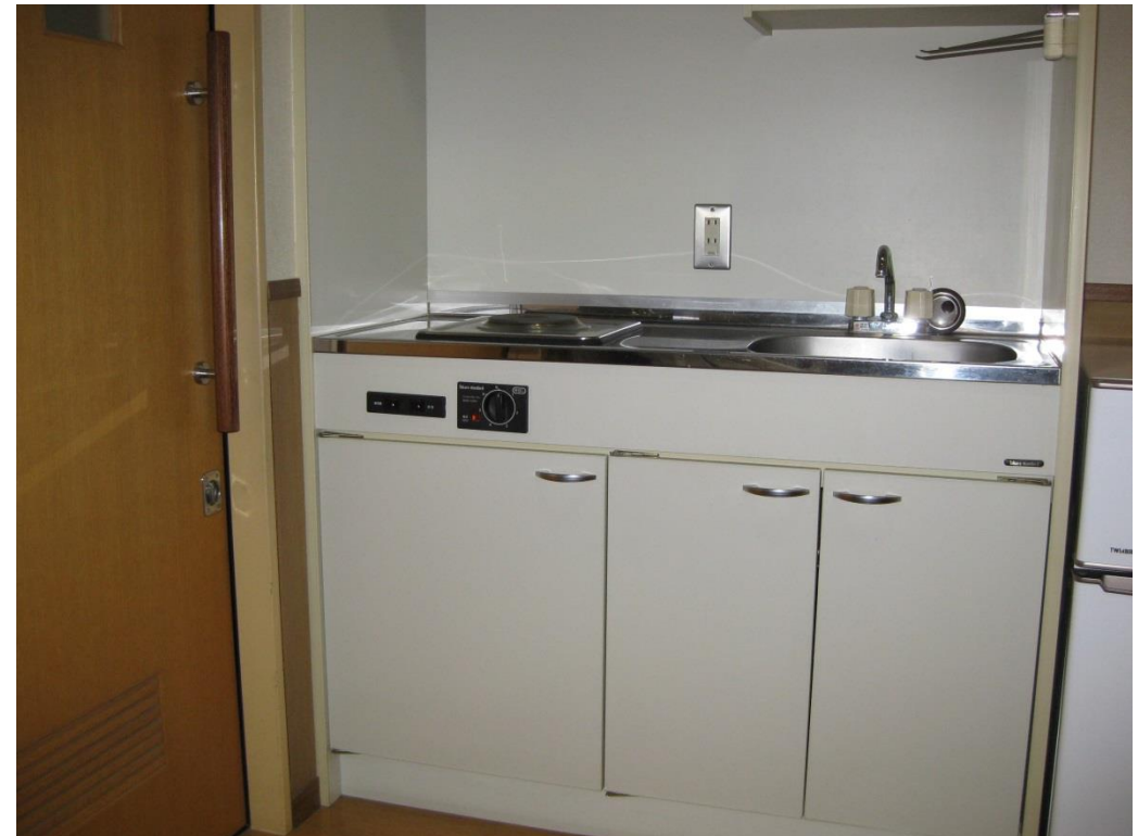
流し台(電気料理器設置)
